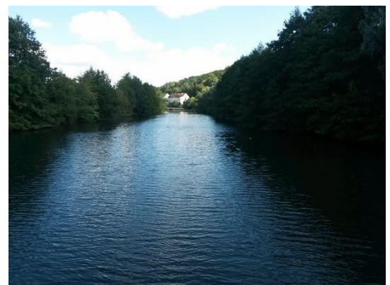
Abbildung 109: Blick zum Wehr
