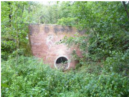
Abbildung 16: Durchlass A8 Ost
