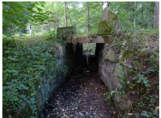
Abbildung 17: Durchlass Barentaler Str.
