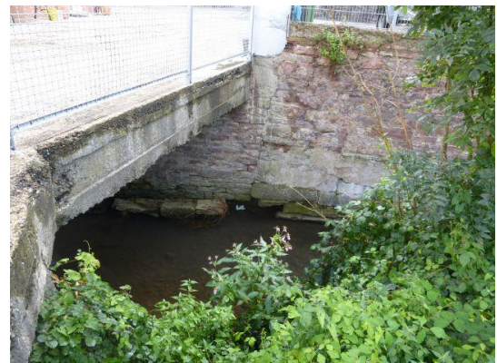
Abbildung 26: Schäden - Unterspülung
