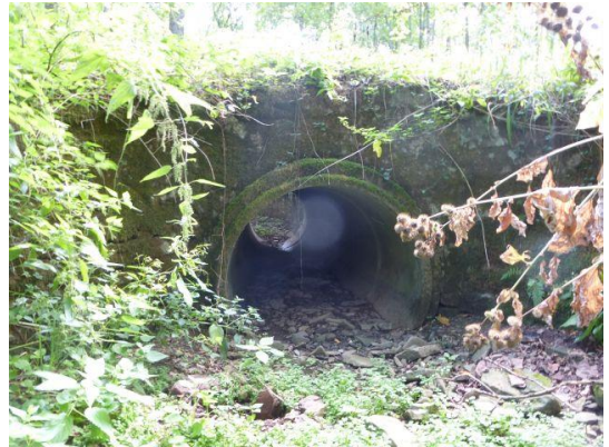
Abbildung 40: Durchlass DN 1200
