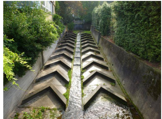
Abbildung 24: Brücke gegen Fließr.
